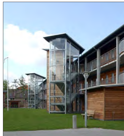
Boliger - Cederhaven på Snerlevej
