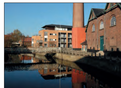
Det gamle elværk ved Kolding Å
